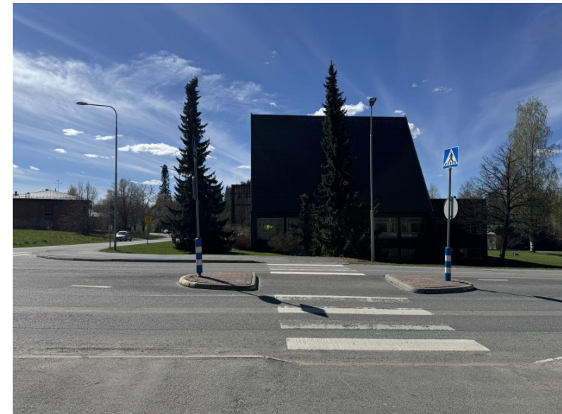
Kuva 15. Tuppuralankadun ja Paukkulantien liittymän saarekkeellinen suojatie
